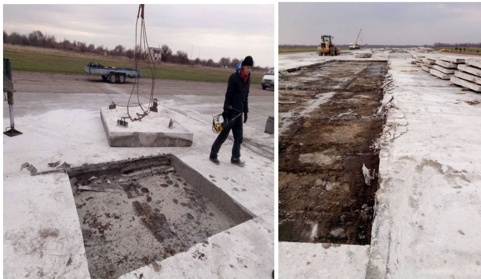
Рис. 6. Демонтаж випиляних плит
