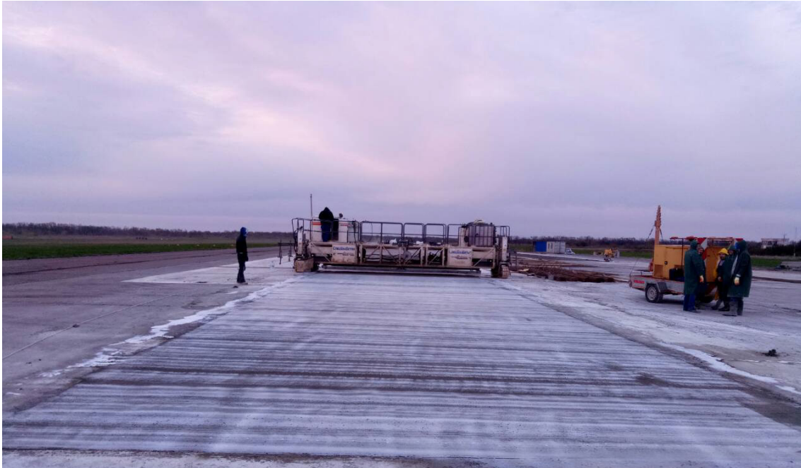
Рис. 7. Укладання цементобетонної суміші на ремонтних ділянках
