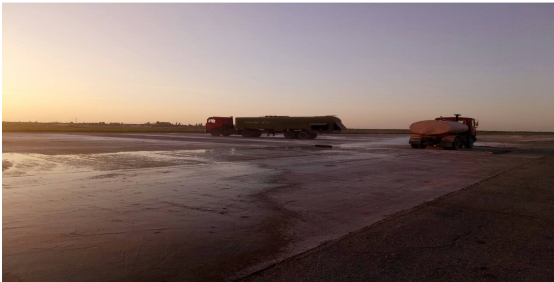
Рис. 8. Догляд і очищення цементобетонного покриття
