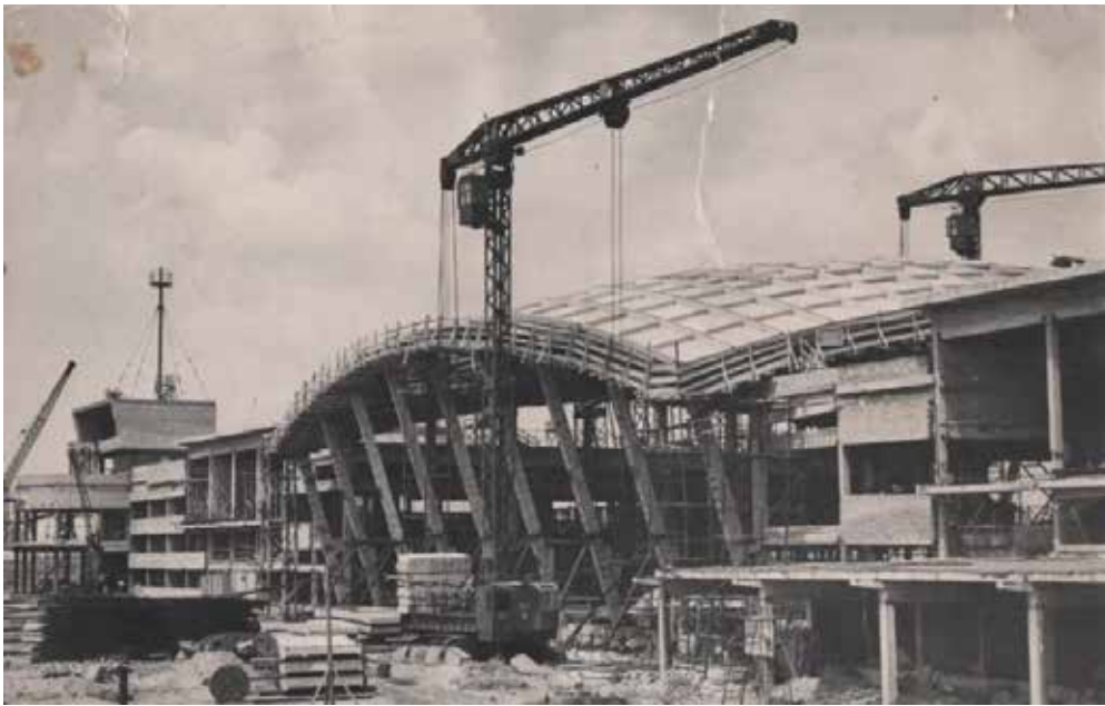
Рис. 10. Будівництво аеровокзалу МА «Бориспіль», монтаж оболонки покриття, 1963 рік
