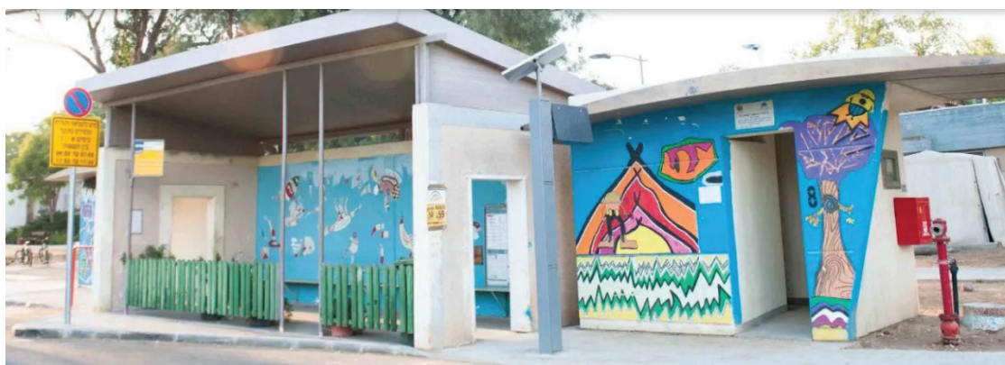
Рис. 4. Мобільне повнозбірне залізобетонне укриття (праворуч) на автобусній зупинці в м. Сдерот на півдні Ізраїлю
