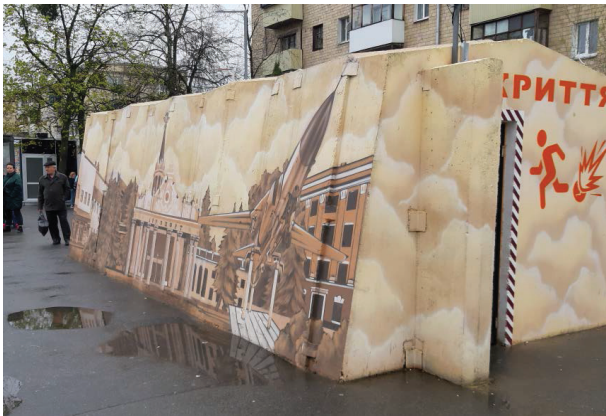
Рис. 10. Збірно-монолітне залізобетонне укриття на Аерокосмічному проспекті в м. Харкові
