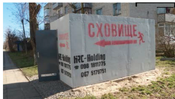
Рис. 9. Повнозбірне залізобетонне укриття в м. Очакові
