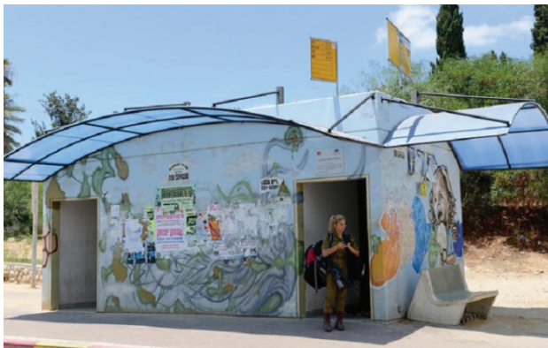
Рис. 6. Сонцезахисні козирки на зблокованих укриттях
