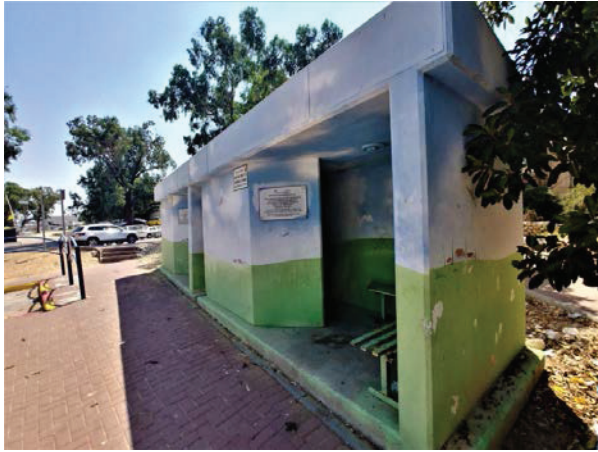
Рис. 8. Приклад монолітного залізобетонного укриття
