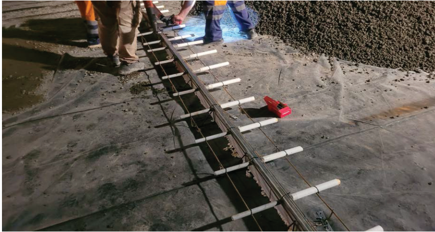
Рис. 1. Улаштування композитної арматури ручним методом
