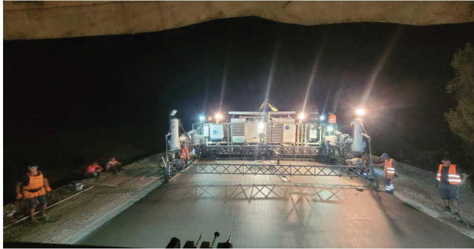
Рис. 3. Будівництво цементобетонного покриття автомобільної дороги високопродуктивними бетоноукладальними комплексами з використанням ковзної опалубки
