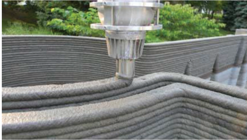
Рис. 3. Процес 3D-будівництва за технологією “Concrete Printing” [20]
