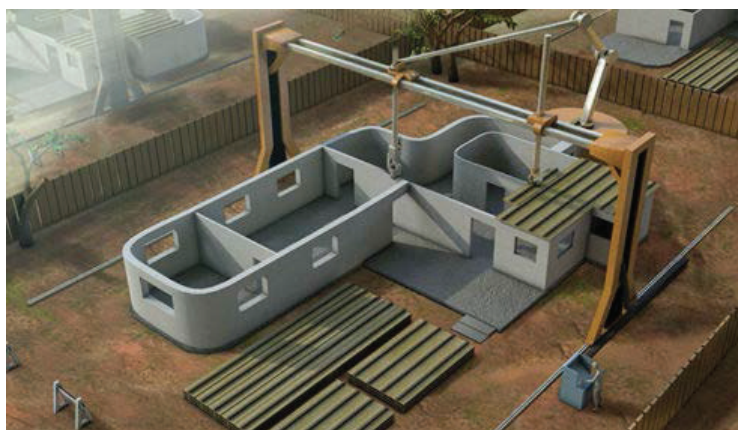
Рис. 2. 3D-установка 3D-друку будівлі за технологією “Contour Crafting” [20]
