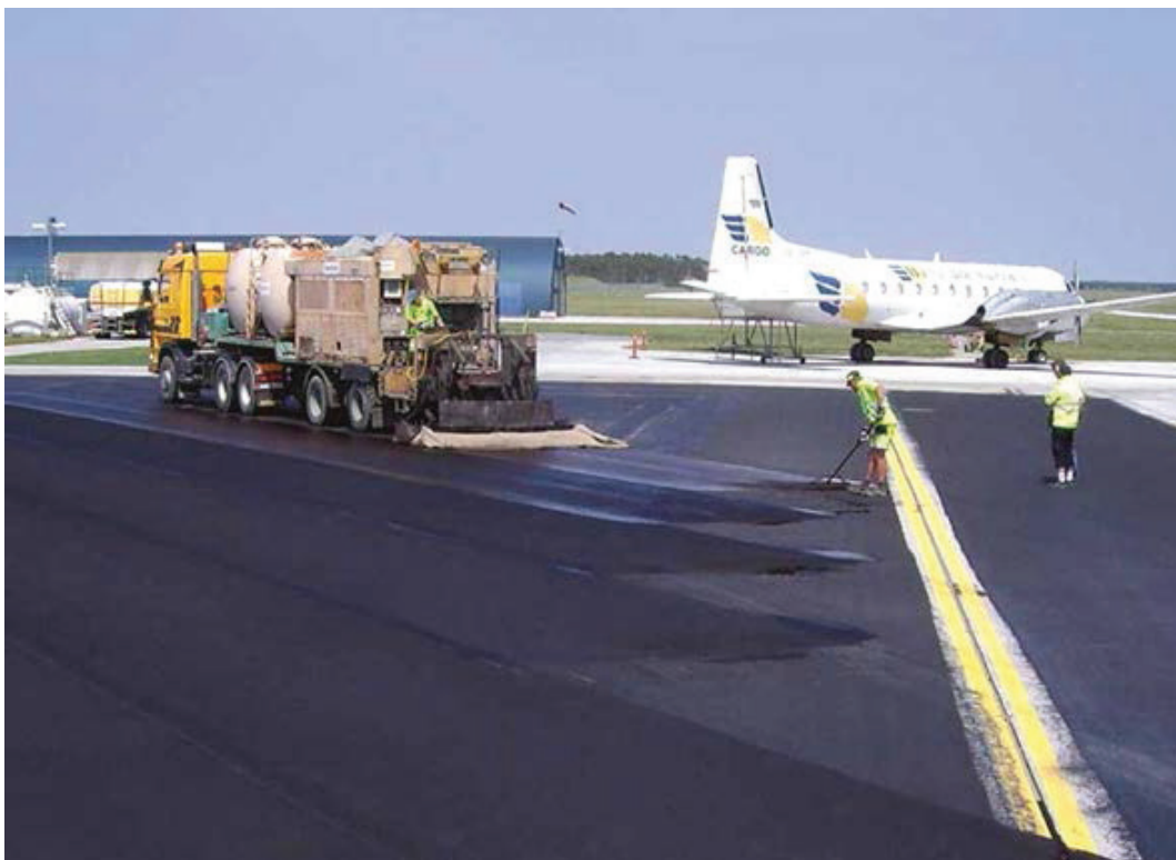
Рис. 1. Приклад улаштування ЛЕМС на аеродромному покритті [49]
