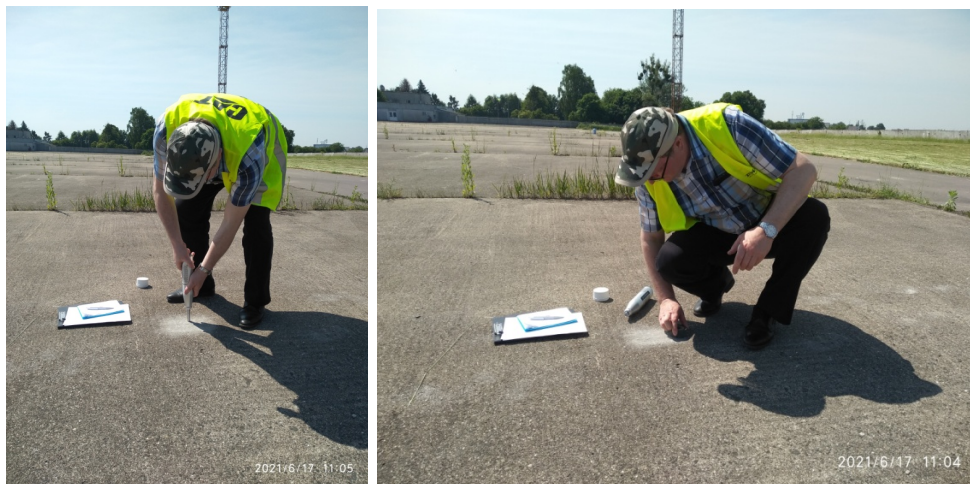
Рис. 10. Вимірювання міцності цементобетонну плит мостового полотна неруйнівним методом
